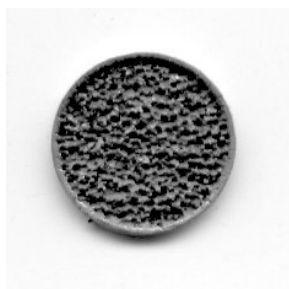
Obr. 2. Korozní narušení konce vlnovodu z hliníku
